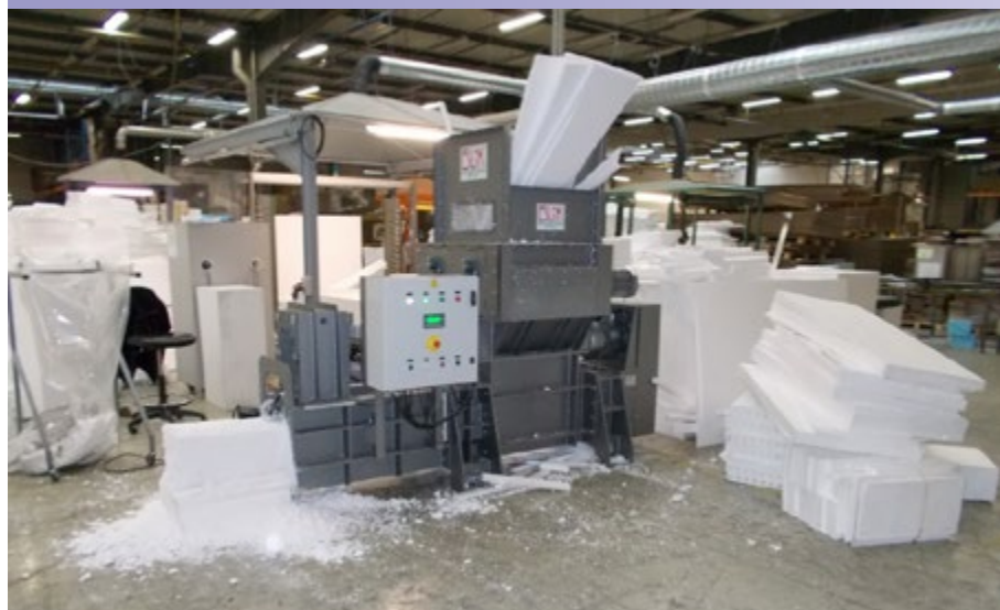
Poly4000 et broyeur 4 arbres de coupe Q700 en pleine production Poly4000 compacter and 4 Q700 cutting trees in full production
